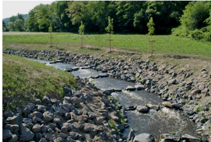
Naturnahe Fischaufstiegsanlage: Gerinne in Nassau an der Lahn
