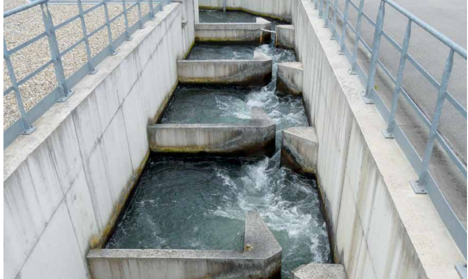
Technische Fischaufstiegsanlage: Becken-Schlitzpass Gamsheim
