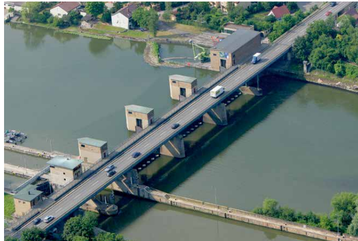
Blick auf die Neckarstaustufe Lauffen mit Wasserkraftwerk
