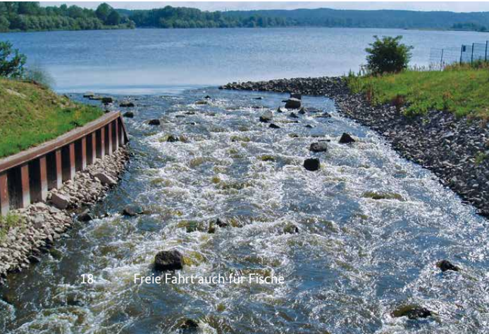
Fischpass am Nordufer der Elbe bei Geesthacht
