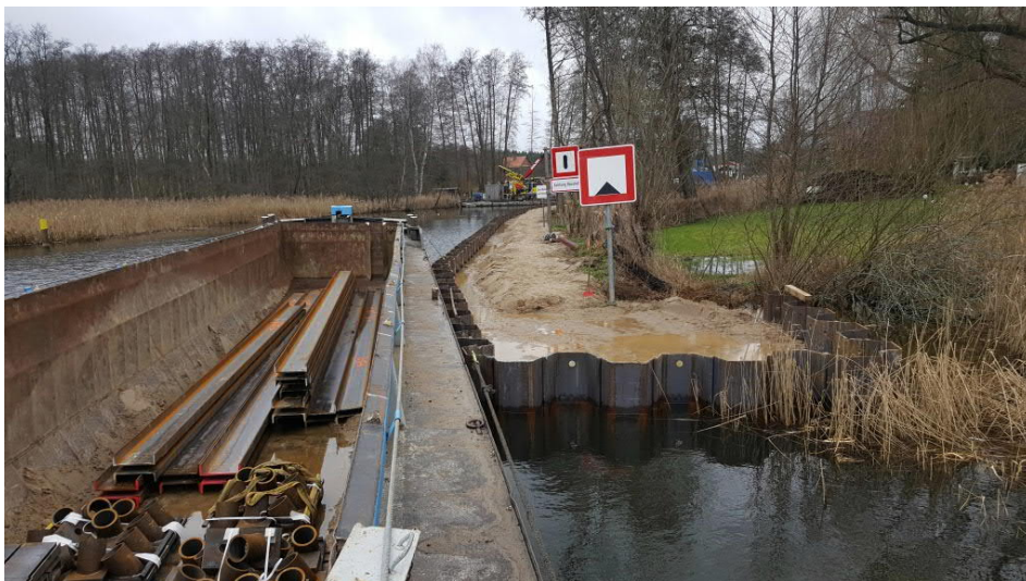
Bild 2: Abschluss der Rammarbeiten im Unteren Vorhafen
