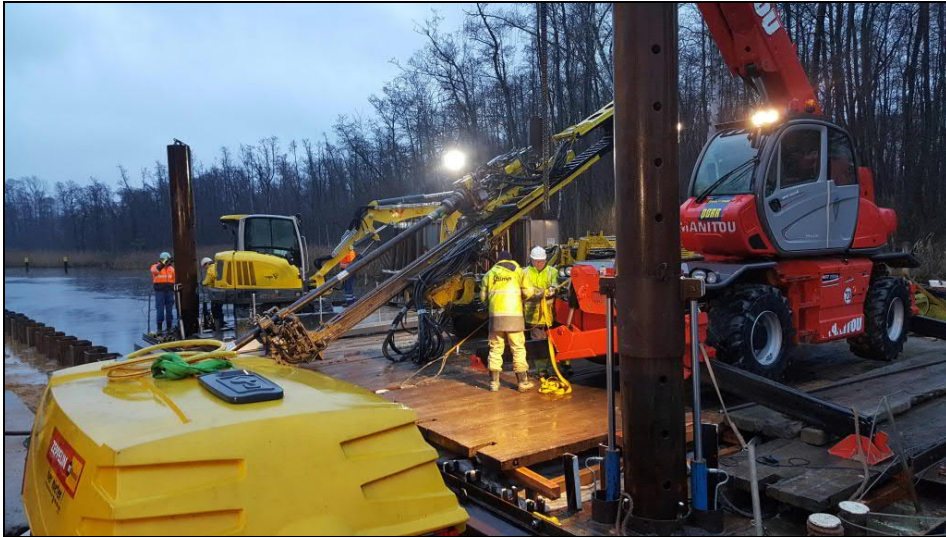
Bild 3: Vorbereitungen für das Einbringen der bis zu 37 m langen Litzenanker im Unteren Vorhafen
