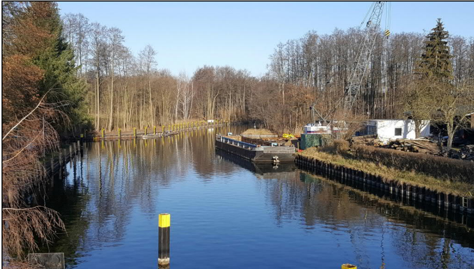
Bild 1: Schleuse Canow mit Blick zum Oberen Vorhafen
