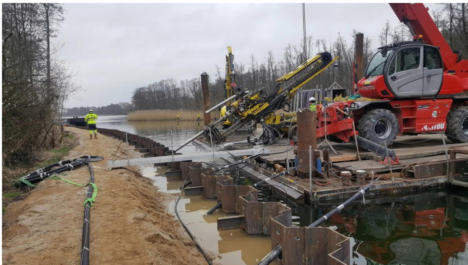
Bild 4: Bohrungsarbeiten für die Litzenanker
