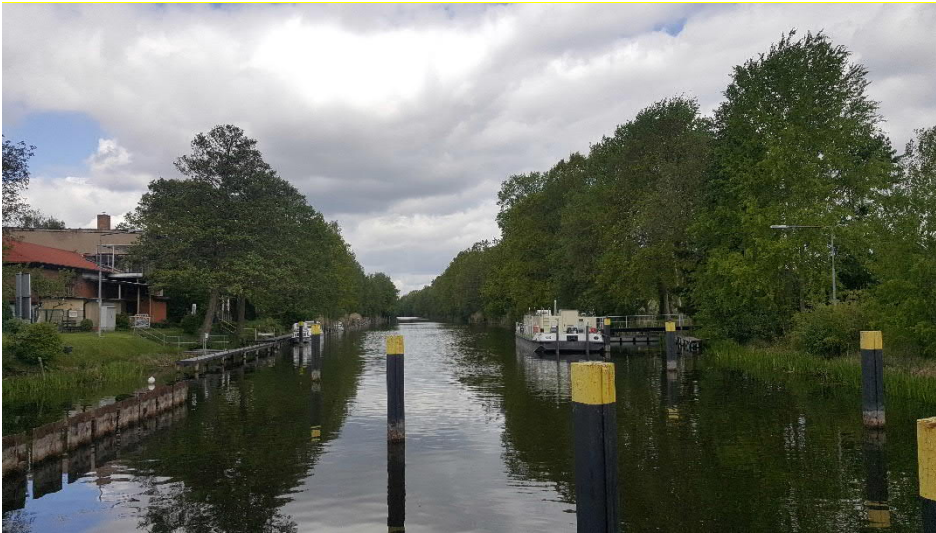
Bild 1: Blick von der Schleuse Mirow zum Oberen Vorhafen
